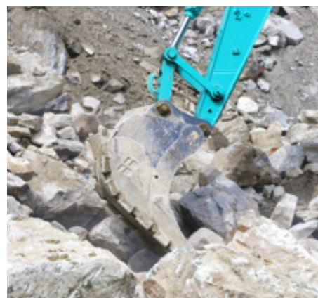
Der fix verbolzte Felstieflöffel der Firma Baumaschinentechnik bewährt sich zur vollsten Zufriedenheit bei den Arbeiten im härtesten Fels.
